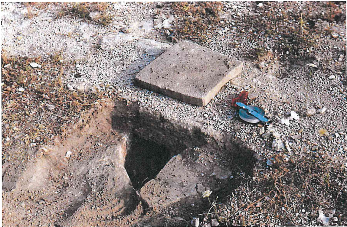
Egout couvert par des briques passant sous un mur en petit appareil
